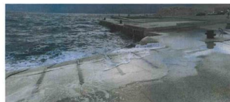
Slika 4. Postojeće stanje obale u trajektnom pristaništu Žigljen
