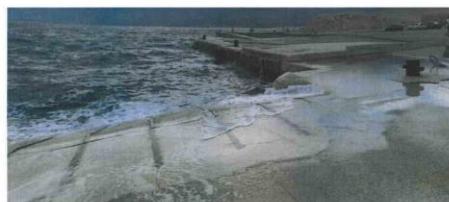
Slika 4. Postojeće stanje obale u trajektnom pristaništu Žigljen
